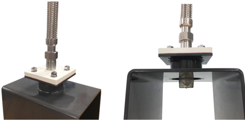
Hình 4.7. Ống mềm chữa cháy dành cho đường ống Duct (Hình lắp đặt thực tế)
