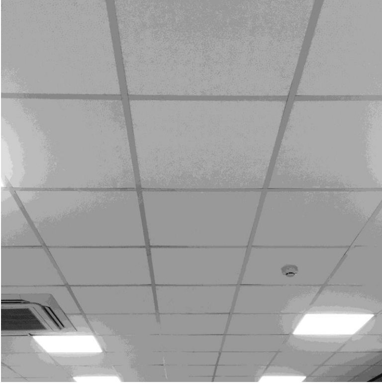
Hình 4.1. Khung trần nổi với tấm thạch cao trong tòa nhà thương mại
